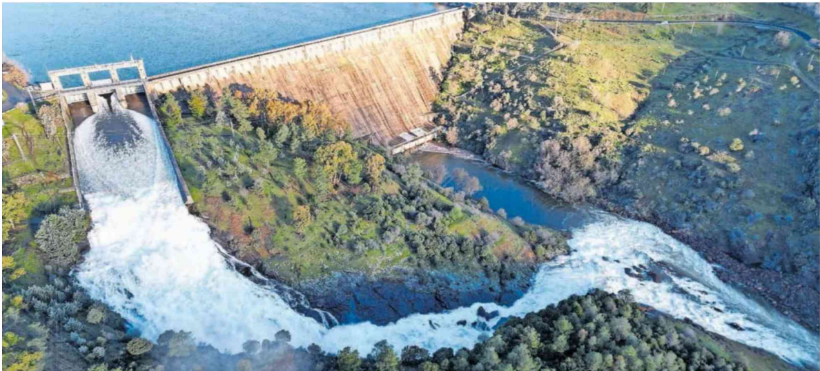
Presa del Burguillo, en Ávila, con las compuertas abiertas para desembalsar agua, en una imagen de la Confederación Hidrográfica del Tajo.
