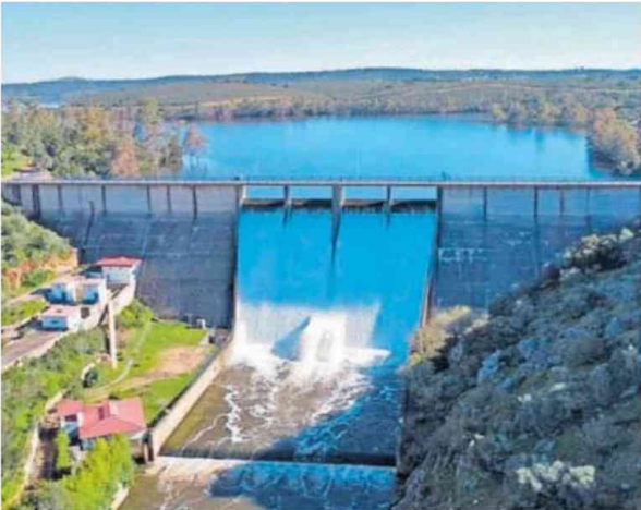
Presa de Villar del Rey, en Badajoz, soltando agua, en una imagen de la Confederación Hidrográfica del Guadiana.
